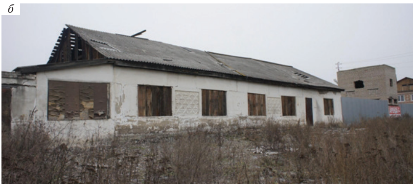
Рис. 25. Дома, построенные на основе гипсовых вяжущих: а — жилой в г. Березовском; б — нежилой в г. Алапаевске (фото из архива доцента кафедры ТВМиСИ УрФУ С. В. Беднягина)
